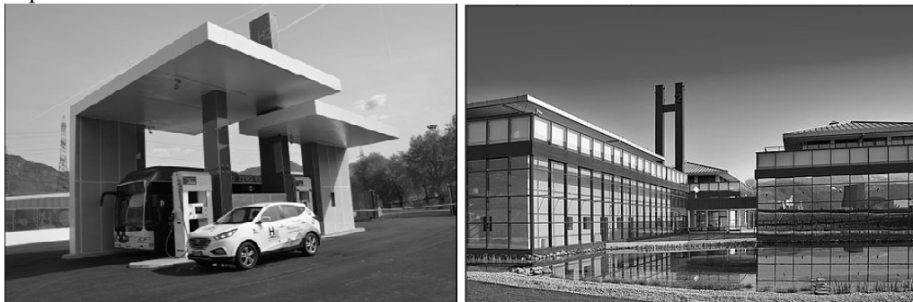
Figura 7: La stazione idrogeno di Bolzano
